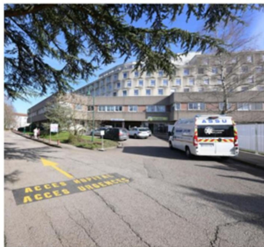
L'hôpital de Verdun, un des établissements du GHT, bénéficie d'importants travaux d'extension. Photo Frédéric Mercenier
